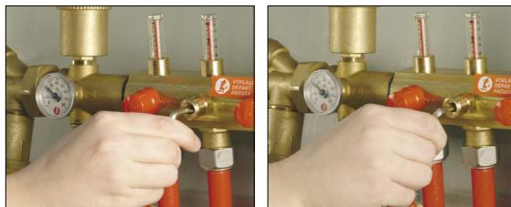
Il collettore di ritorno R553V è dotato di valvole di intercettazione micrometriche termostatiche che consentono regolazione e chiusura dei circuiti manualmente.
